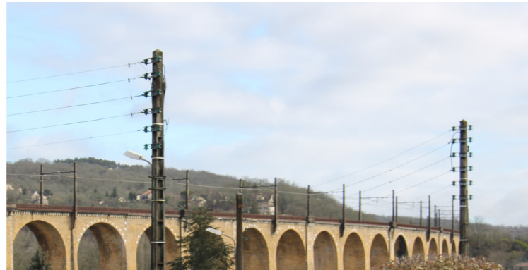
Réseau électrique et viaduc, Souillac Source : ARTIFEX 2022
