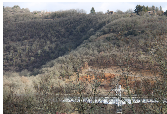
Vallon de Blagour et viaduc Source : ARTIFEX 2022
