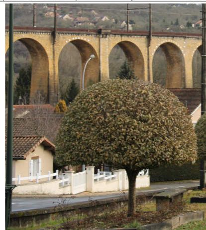
MHi 6 - Viaduc de la Borrèze Source : ARTIFEX 2021
