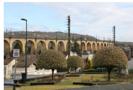
Viaduc de la Borrèze à Souillac Source : ARTIFEX 2022
